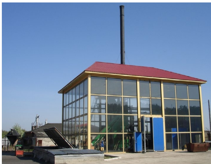
Рис.1. Общий вид промышленной установки с топливным складом.
