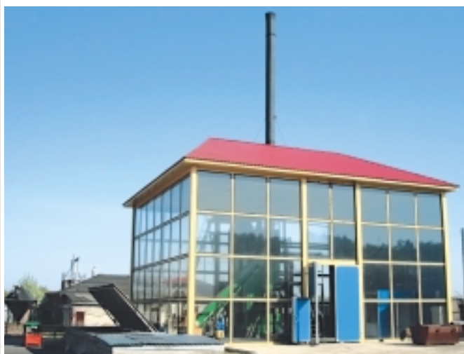
Рис. 1. Общий вид промышленной установки с топливным складом
